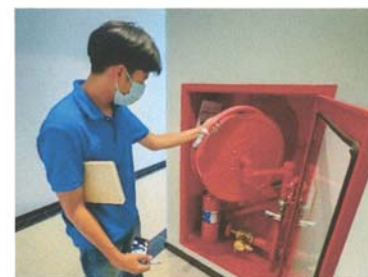
รูปที่ 2.24 ตู้สายฉีดน้ำดับเพลิง
