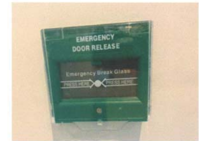
รูปที่ 2.37 ปุ่มเปิดประตูดุฉุกเฉิน
