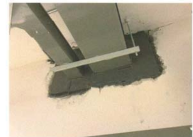
รูปที่ 2.49 การปิดกันพื้นที่ที่มีความเสี่ยงสูง
