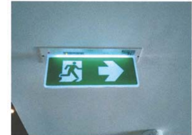
รูปที่ 2.35 ป้ายไฟบอกทางออกหนีไฟ
