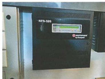
รูปที่ 2.32 Fire Control Panel
