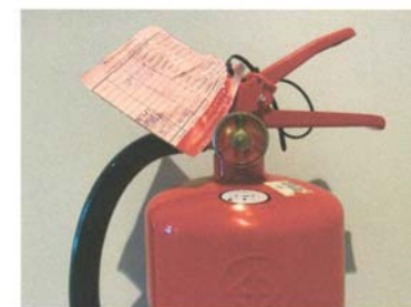
รูปที่ 2.25 ถังดับเพลิงมือถือ (สภาพดีและความดันปกติ)
