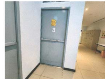
รูปที่ 2.36 ประตุนิไฟ (ปิดสนิท มีป้ายบอกเลขชั้นชัดเจน)
