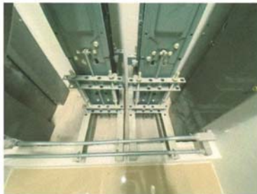
รูปที่ 2.42 การปิดกั้นช่องว่างระหว่างชั้น (ชาฟท์ไฟฟ้า)
