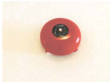
รูปที่ 2.30 กระดิ่งแจ้งเตือน (ปกติขณะทดสอบ)
