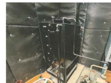
รูปที่ 2.23 ถังน้ำมันของเครื่องกำเนิดไฟฟ้าสำรอง
