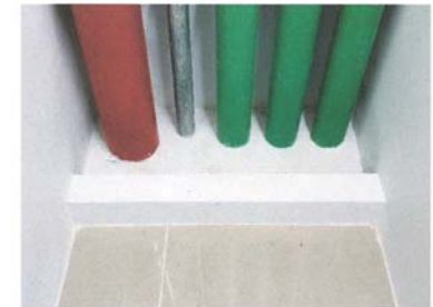
รูปที่ 2.47 การปิดกันช่องว่างระหว่างชั้น (ชาฟท์ท้อ)
