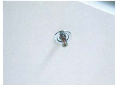
รูปที่ 2.29 Sprinkler
