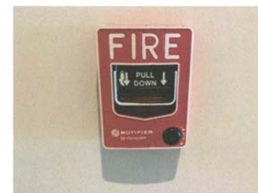
รูปที่ 2.27 อุปกรณ์แจ้งเหตุด้วยมือ (ปกติขณะทดสอบ)
