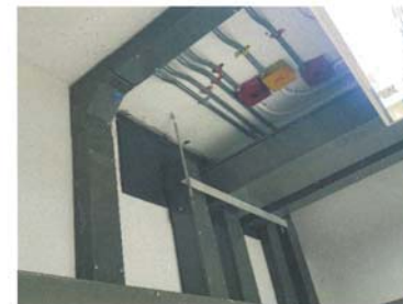
รูปที่ 2.48 การปิดกันพื้นที่ที่มีความเสี่ยงสูง
