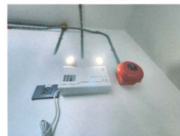
รูปที่ 2.26 ไฟส่องสว่างฉุกเฉิน (ใช้งานได้ปกติ)
