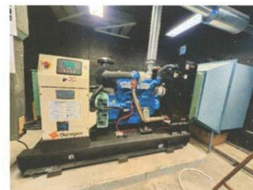
รูปที่ 2.22 เครื่องกำเนิดไฟฟ้าสำรอง
