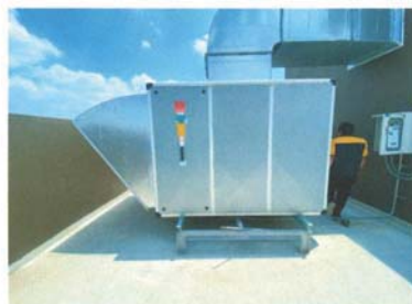
รูปที่ 2.19 ระบบอัดอากาศในช่องบันไดหนีไฟ
