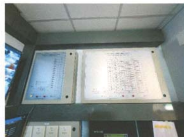
รูปที่ 2.33 Graphic Annunciator
