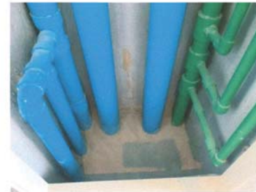
รูปที่ 2.46 การปิดกันช่องว่างระหว่างชั้น (ชาฟท์ท้อ)
